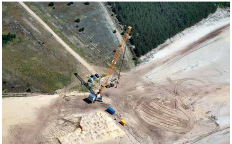
Baustelle Malxe aus der Luft
