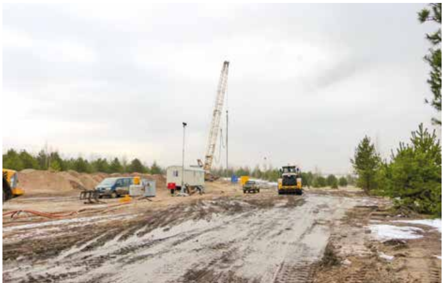
RDV-Baustelleneinrichtung im Cottbuser Ostsee
