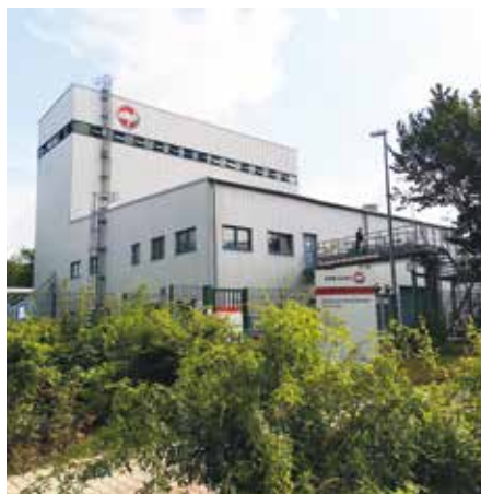
Außenansicht Biomasseheizkraftwerk Sellessen
