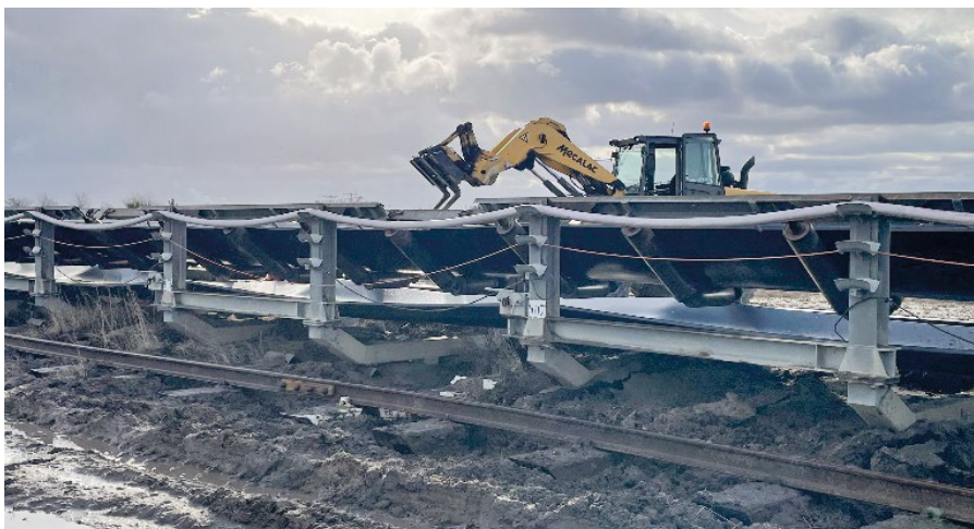
Arbeiten an der Bandanlage
