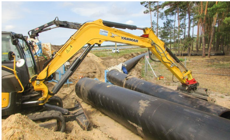
Verlegung der PE-Leitung am Hafen
