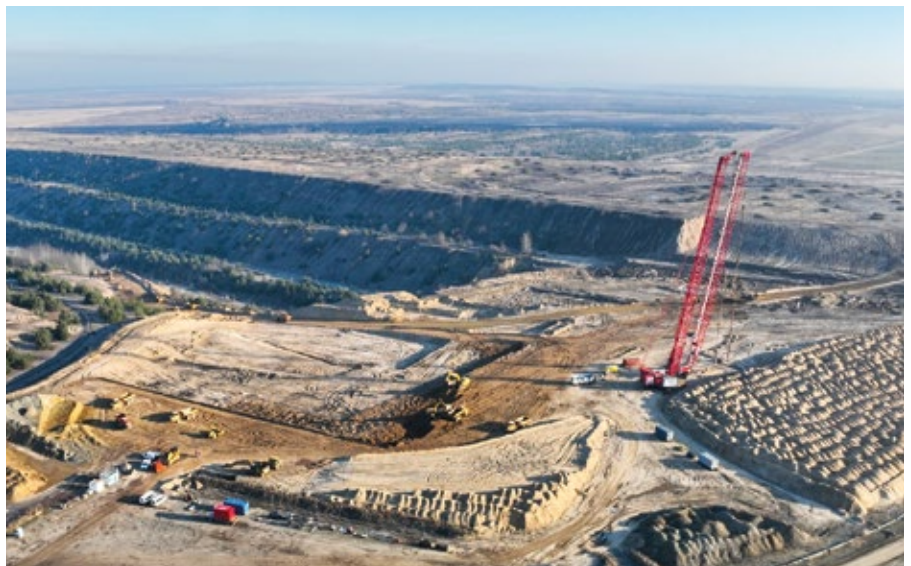
Abb. 1 – Drohnenflug über die Baustelle Maßnahme 3 inkl. Testfeld 1 RDV
