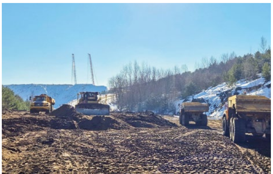
Abb. 3 – lagenweiser Einbau Stützkörper
