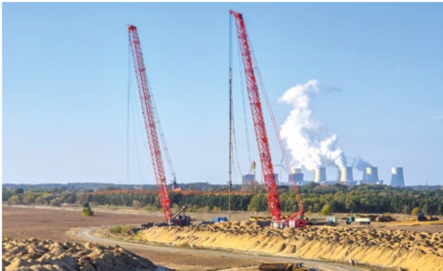
Abb. 2 – Unsere beiden großen Kräne warten auf den Einsatz
