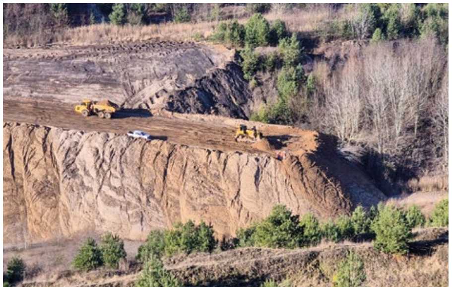
Abb. 2 – Rampenbau für Maßnahme 3
