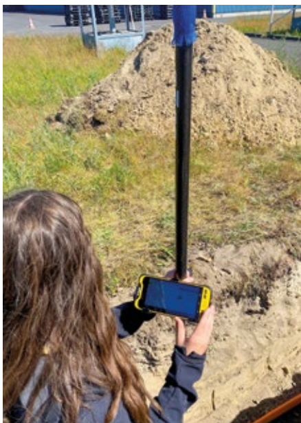
Vermessungsarbeiten im Industriepark Schwarze Pumpe
